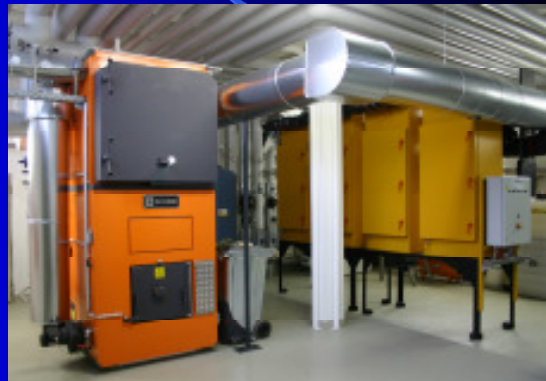
wassergekühlte Vorschubrostfeuerung
